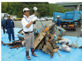
廃棄物の撤去作業の様子
