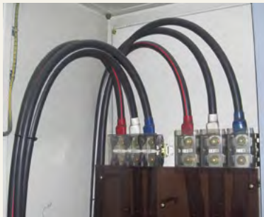
時間のかかる配電盤内の配線作業
