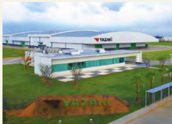
『やわらか電線』を製造しているタイ矢崎電線(株)のスワンナプーム工場
