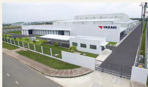
ベトナム新電線工場全景
